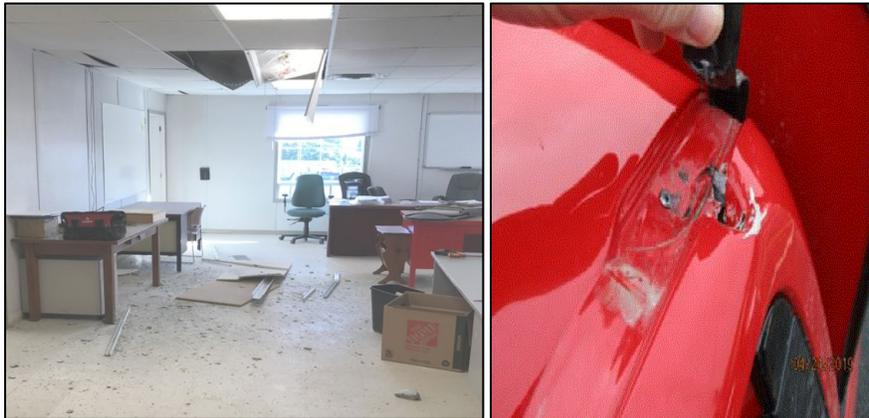
Figure 1 – Des éclats ont causé des dommages à un roulotte de chantier et à un camion stationné lors de deux incidents de dynamitage.
