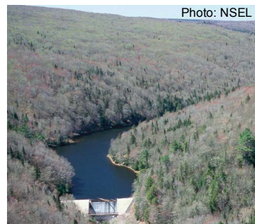
Photo: NSEL James River – source d'eau potable de la ville d'Antigonish
